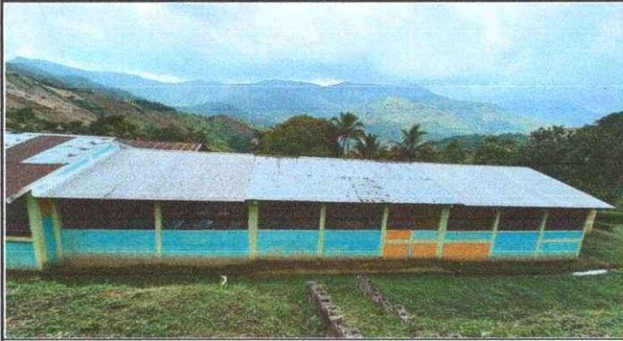
Foto1: Se observa el deterioro de las laminas del modulo 1.
