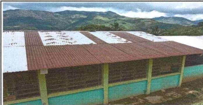
Foto 5: Se oberva el deteriro de las laminas portantes del modulo 2
